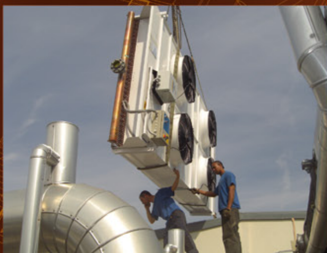
Mise en place de par le toit du système d'aération.
