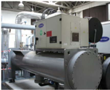
Installation du groupe de froid
